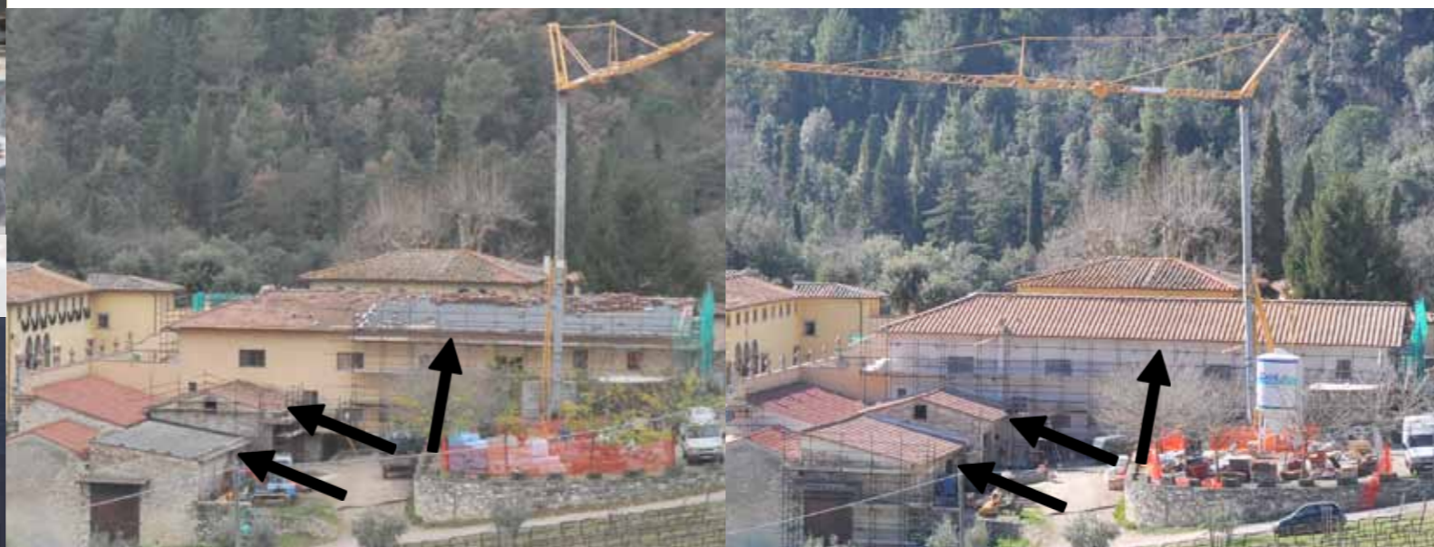
Vue d'ensemble du chantier de la Phase n°3 : à gauche, au début du mois de décembre 2016 et à droite au mois de mars 2017.
