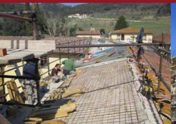
Mars 2015 : pose de la chape et de l'étanchéité
