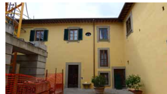
La cour intérieure lors du montage des échafaudages et après restauration. On aperçoit les blocs en béton qui maintiennent le pied de la grue : le poids de chacun d'entre eux varie entre 800 et 2500 kg pour les plus longs.
