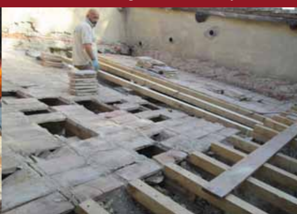
Octobre 2014 : la charpente en cours de réfection
