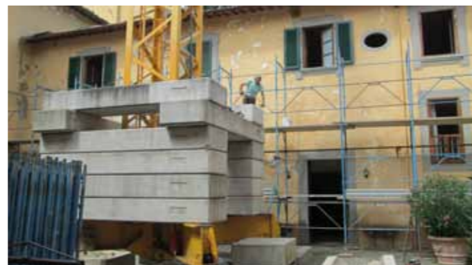
La cour intérieure lors du montage des échafaudages et après restauration. On aperçoit les blocs en béton qui maintiennent le pied de la grue : le poids de chacun d'entre eux varie entre 800 et 2500 kg pour les plus longs.
