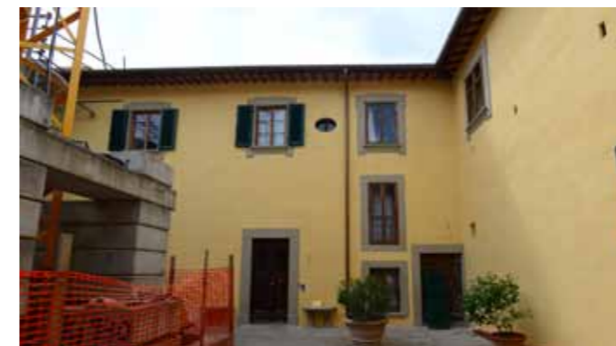
La cour intérieure lors du montage des échafaudages et après restauration. On aperçoit les blocs en béton qui maintiennent le pied de la grue : le poids de chacun d'entre eux varie entre 800 et 2500 kg pour les plus longs.
