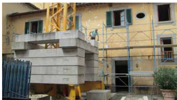
La cour intérieure lors du montage des échafaudages et après restauration. On aperçoit les blocs en béton qui maintiennent le pied de la grue : le poids de chacun d'entre eux varie entre 800 et 2500 kg pour les plus longs.
