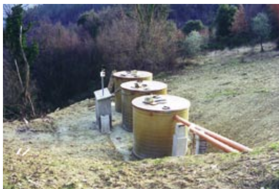
Les fosses septiques enfin installées !
