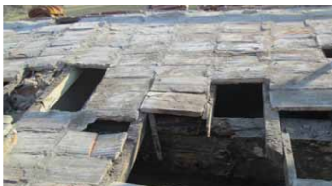
État des toits lorsque les tuiles ont été retirées. On aperçoit la poutre principale, fortement attaquée par les infiltrations. Photo de droite, le toit refait avec une partie des tuiles anciennes ; on aperçoit à gauche l'étanchéité posée sous les tuiles.
