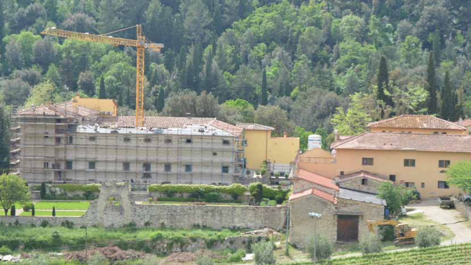
Gricigliano en mai 2015 : la plus grande partie des toits de la Villa est restaurée.
