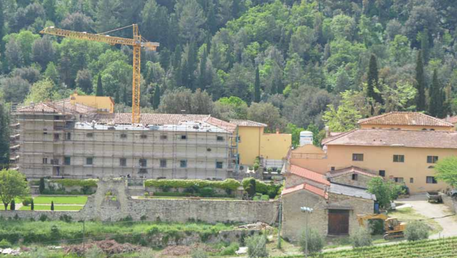
Gricigliano en mai 2015 : la plus grande partie des toits de la Villa est restaurée.
