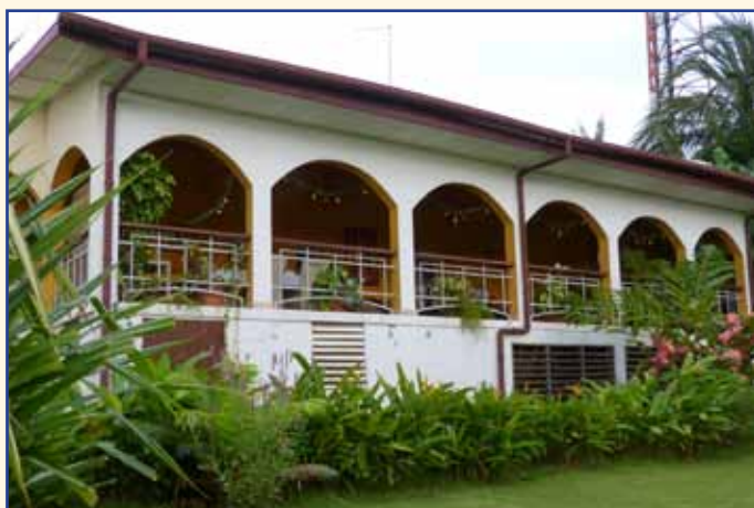
... et ci-dessus la même maison dix ans après, entièrement rénovée et rebaptisée maison des chanoines. Trois grandes pièces ont été aménagées, libérant autant d'espace dans la maison principale pour les activités du patronage.
