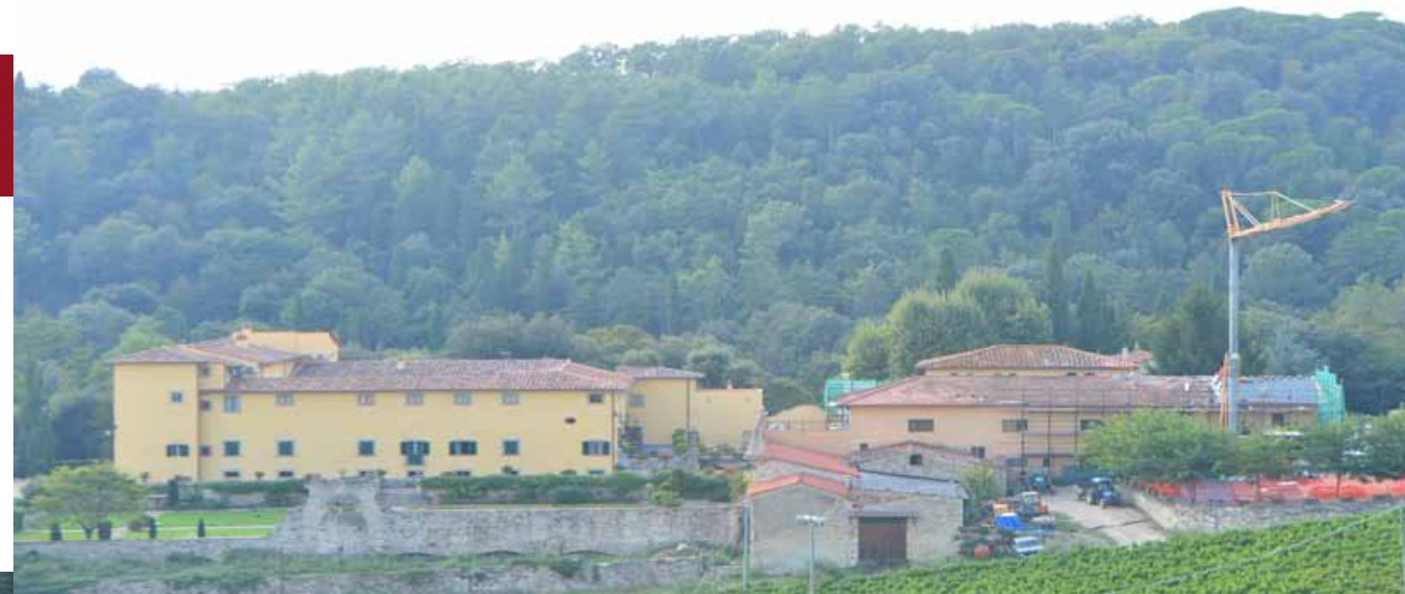
Veduta del Seminario: la Villa Martelli a sinistra, rinnovata tra il 2014 ed il 2015, l'edificio Santa Maria a destra, in corso di restauro.
