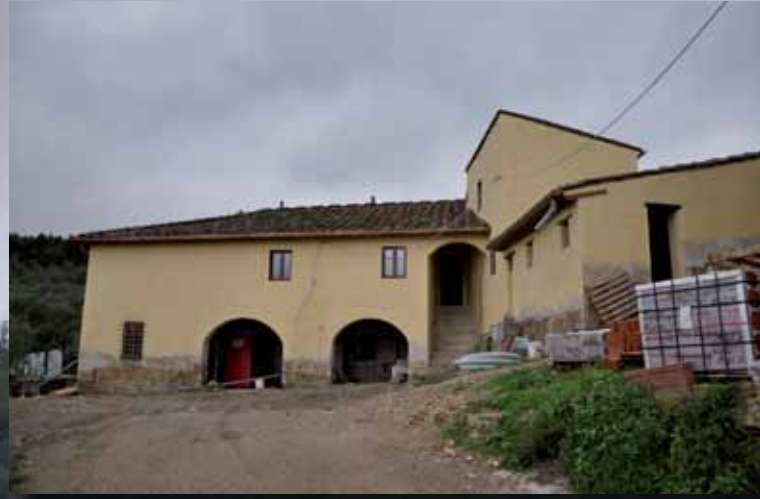
La nuova facciata è stata imbiancata nel colore tradizionale in Toscana.
