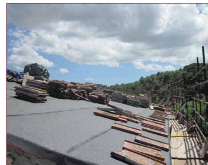
Lavori sul tetto della casa colonica.
